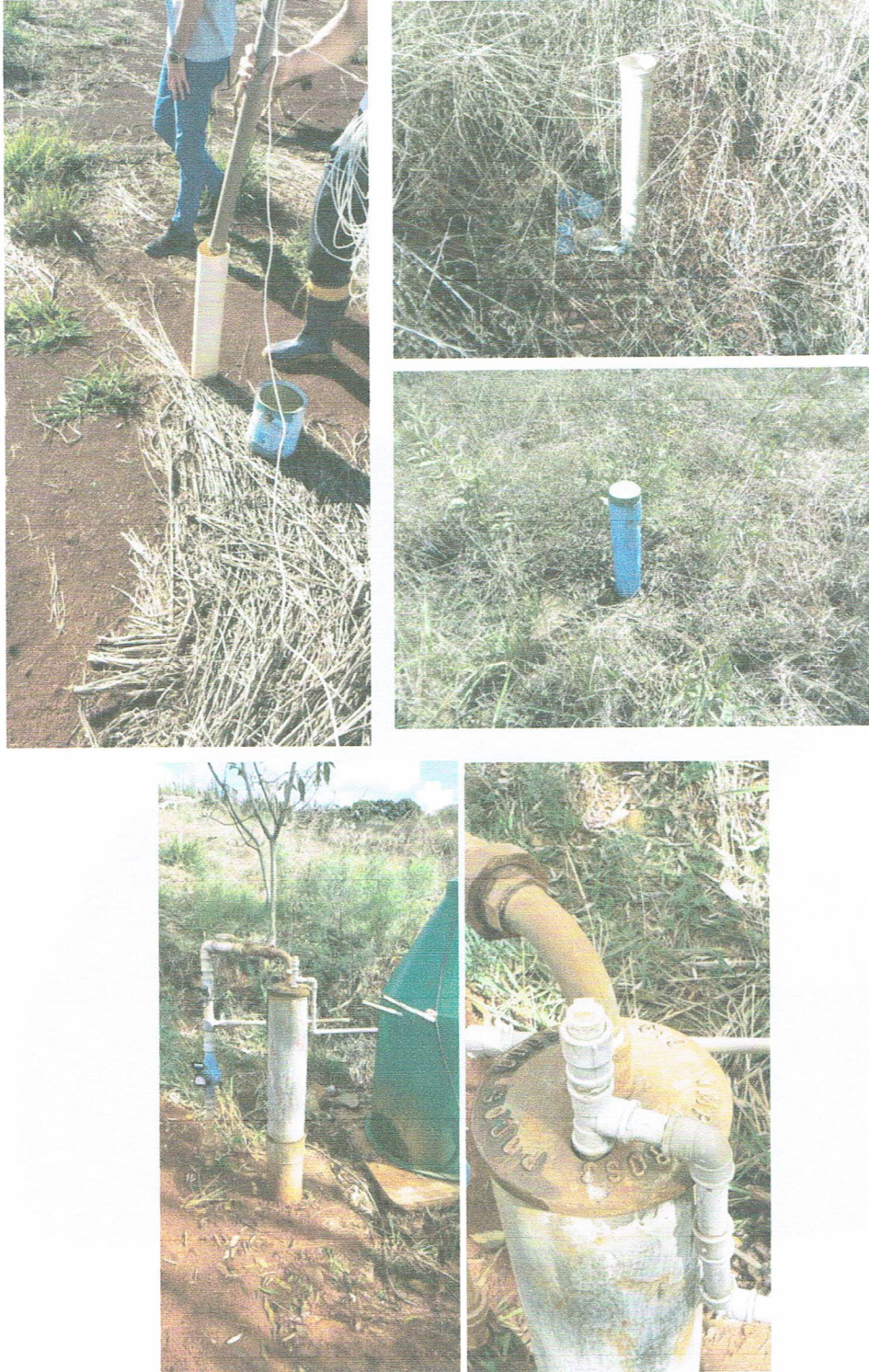
Figura 3: Registro fotográfico dos poços de monitoramento e poço tubular
